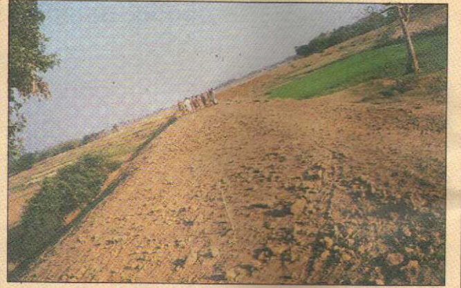
দ্বারকা নদের সরলপুরের (মরগ্রাম) ডান তীরের বাঁধের মেরামতির কাজ, জেলা : বীরভূম
