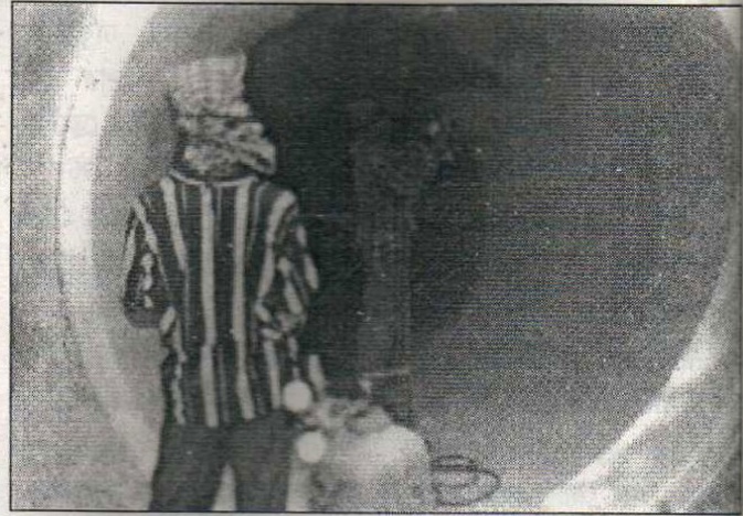
গলানো ধাতুর প্রলেপ উত্তর ভাগের যন্ত্রাংশে আরোপ করা হচ্ছে।
